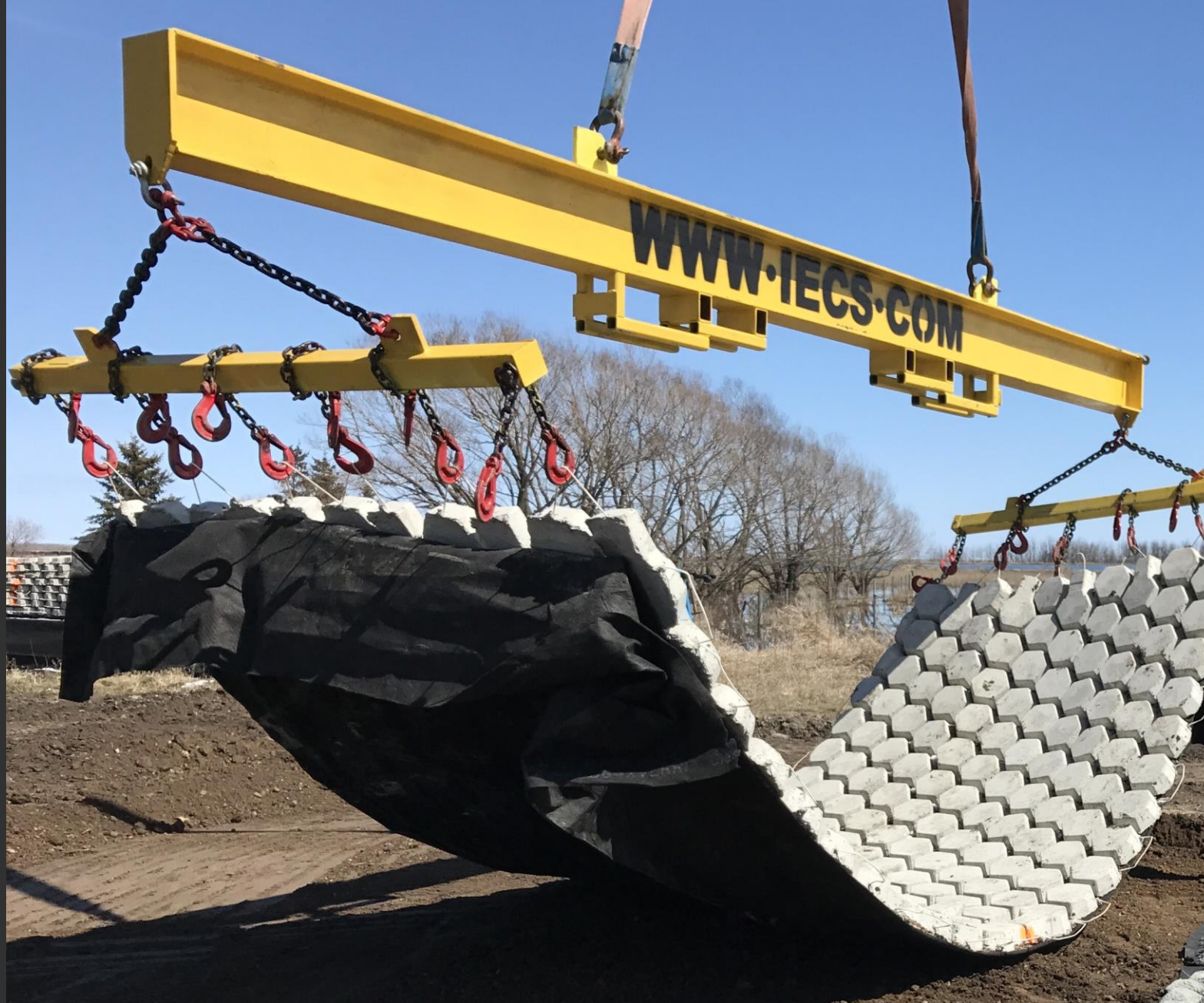
Típica Malla Cable Concrete
