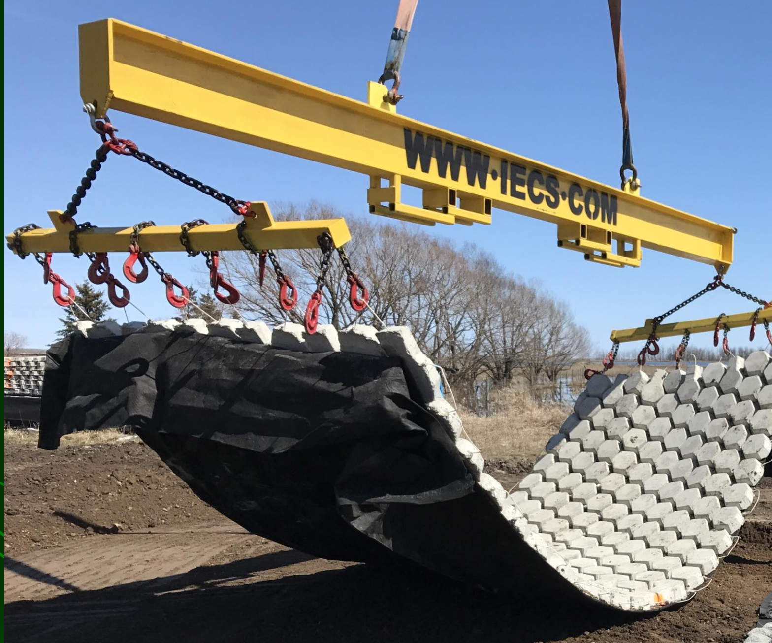
Típica Malla Cable Concrete
